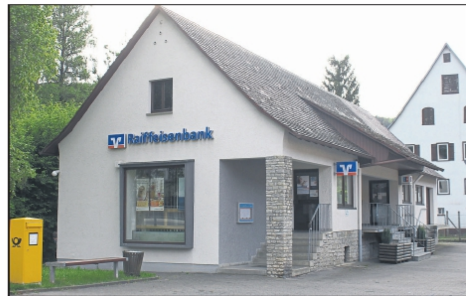
Bis zur Eröffnung der Filiale in der Johanniterstraße werden die Kunden weiterhin am Standort Kugelwasen (Bild) bedient.
